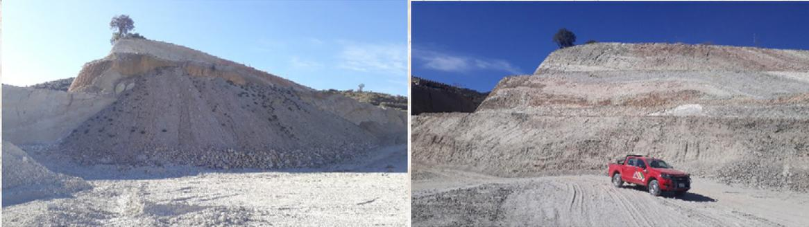
Posteriormente se inició la remoción del anticlinal del Frente 2, labor que aún no se completó debido a la paralización de actividades. Se ha realizado explotación selectiva en el flanco Norte del pliegue anticlinal y una remoción total como estéril de la parte superior del pliegue correspondiente a la charnela. Esta actividad se realizó hasta fecha 19 de mayo.
